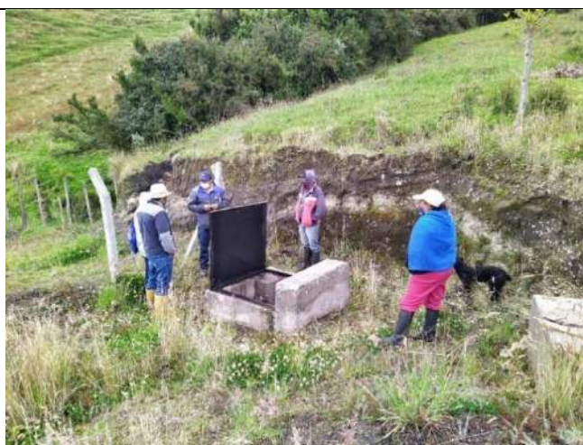
Recorrido del sistema de riego en Concepción de Monjas para reforzarlo y evitar roturas de la tubería de conducción.
