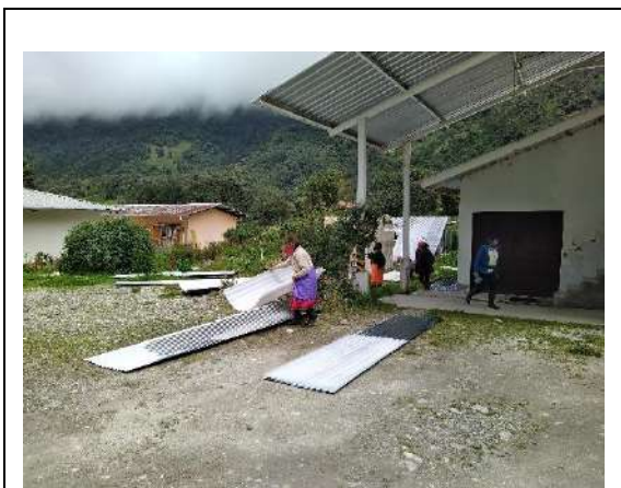
Entrega materiales para construcción de hospedaje de gallinas ponedoras felices
