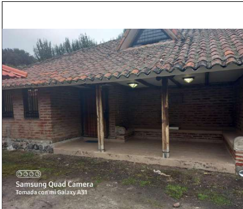
Campamento de Paluguillo, Se aplicó barniz en la fachada para evitar el deterioro del ladrillo
