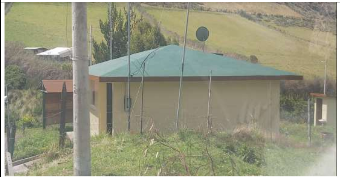
Mantenimiento de fachada del control de Pushipungo.
