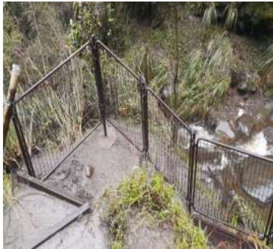
Cerramiento completo de la plataforma de la cascada
