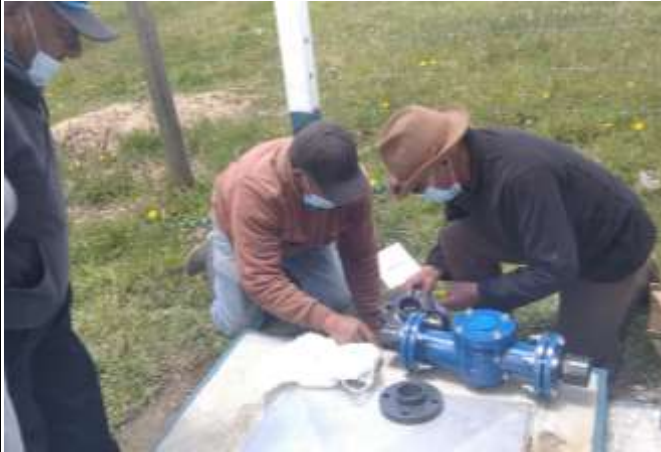
Instalación del sistema de desinfección
