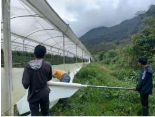
Rehabilitación de invernaderos, apertura de ventanas y cambio de cables que sostienen la estructura, Oyacachi.
