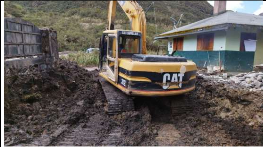
Desalojo de estructuras existentes y consolidación de terraplén en la parte posterior del campamento de baños.
