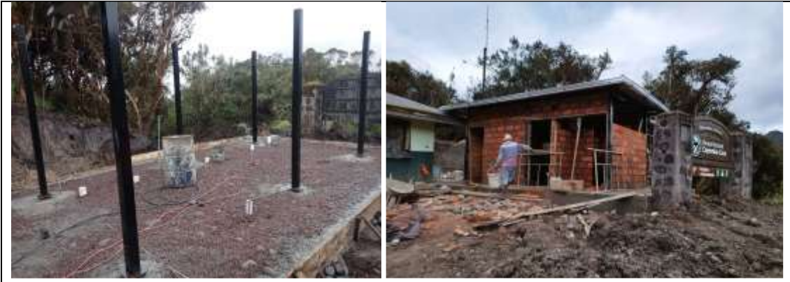
Colocación de estructura y mampostería de las baterías sanitarias.
