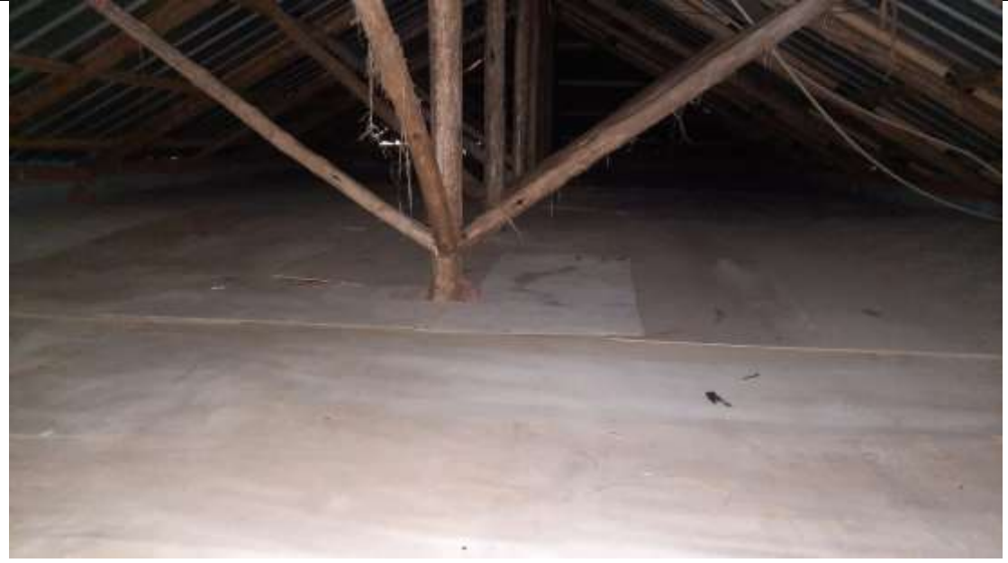
Adecuación de piso y parte del tumbado.
