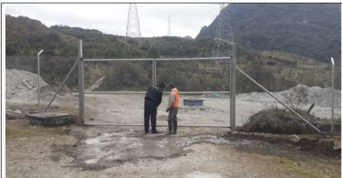
Cerramiento de malla en la entrada del túnel Quito, adosada a la garita.
