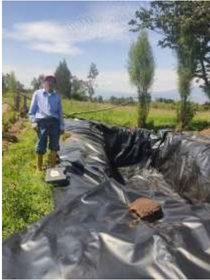
Adquisición e instalación de Geomembrana y dos bombas de agua, Iguiñaro
