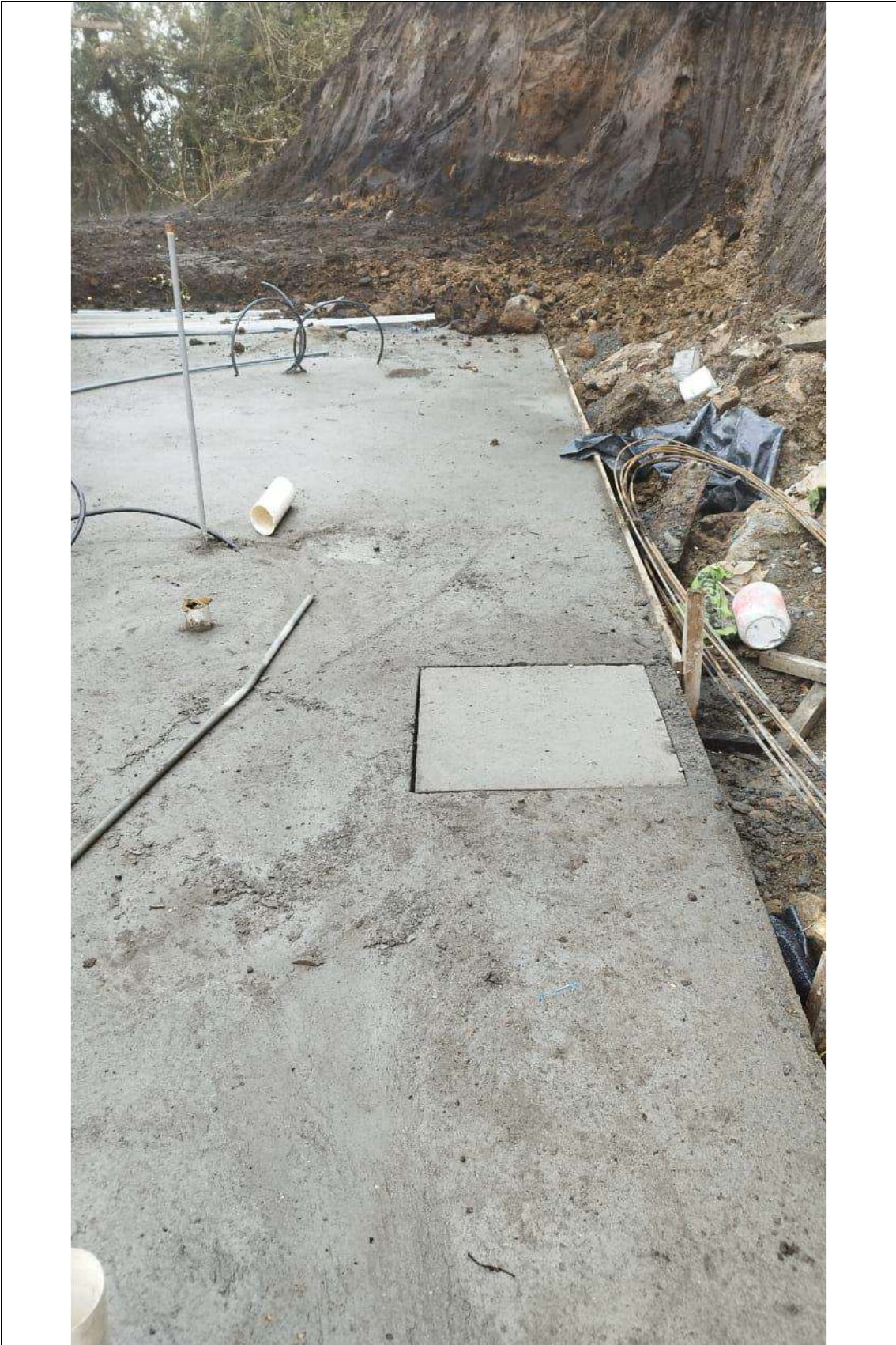
Fundición del piso
