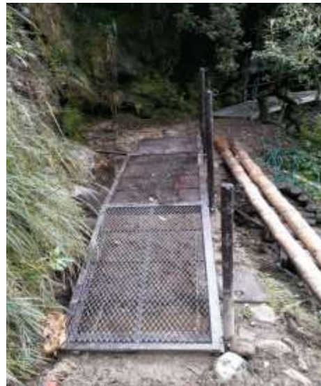
Segundo tramo del puente
