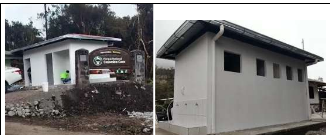
Parte externa de las baterías sanitarias.
