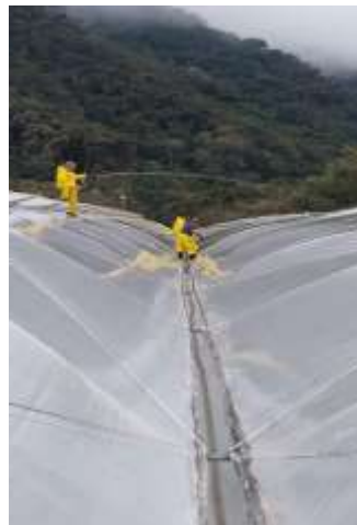
Rehabilitación de invernaderos, cambio de poli 100 que ayuda a sostener la cubierta y limpieza del plástico para darle mayor vida útil, Oyacachi.
