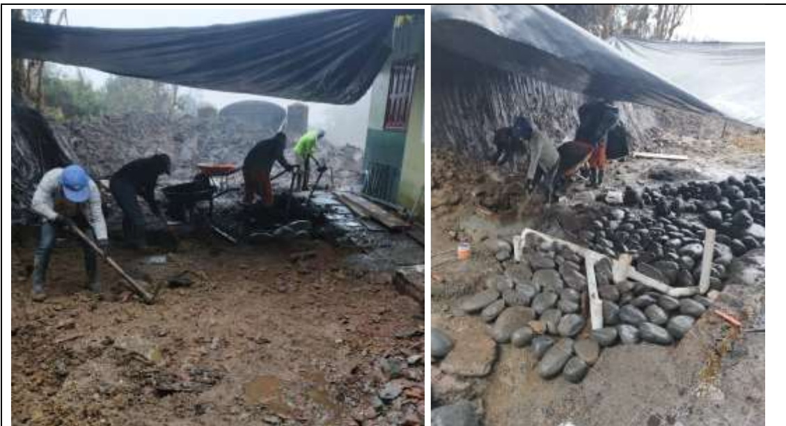
Nivelación y cimentación del contrapiso.
