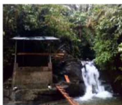
Captación San Sebastián
