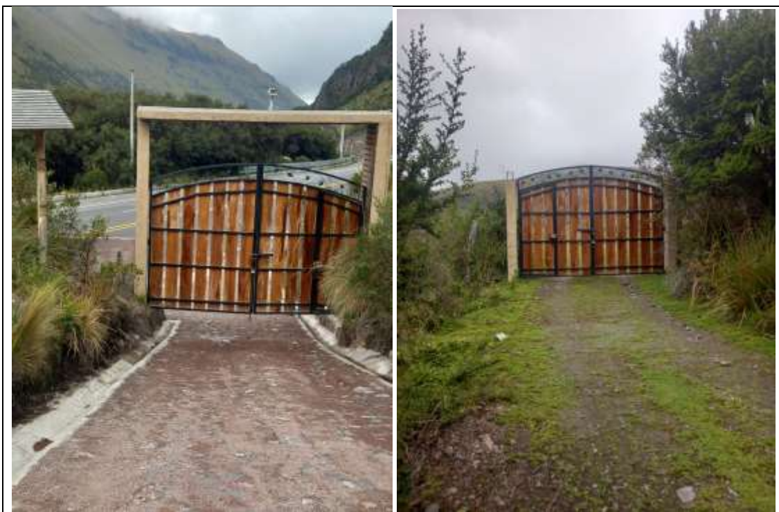
Portones de los ingresos principales de la vía principal uy antigua.
