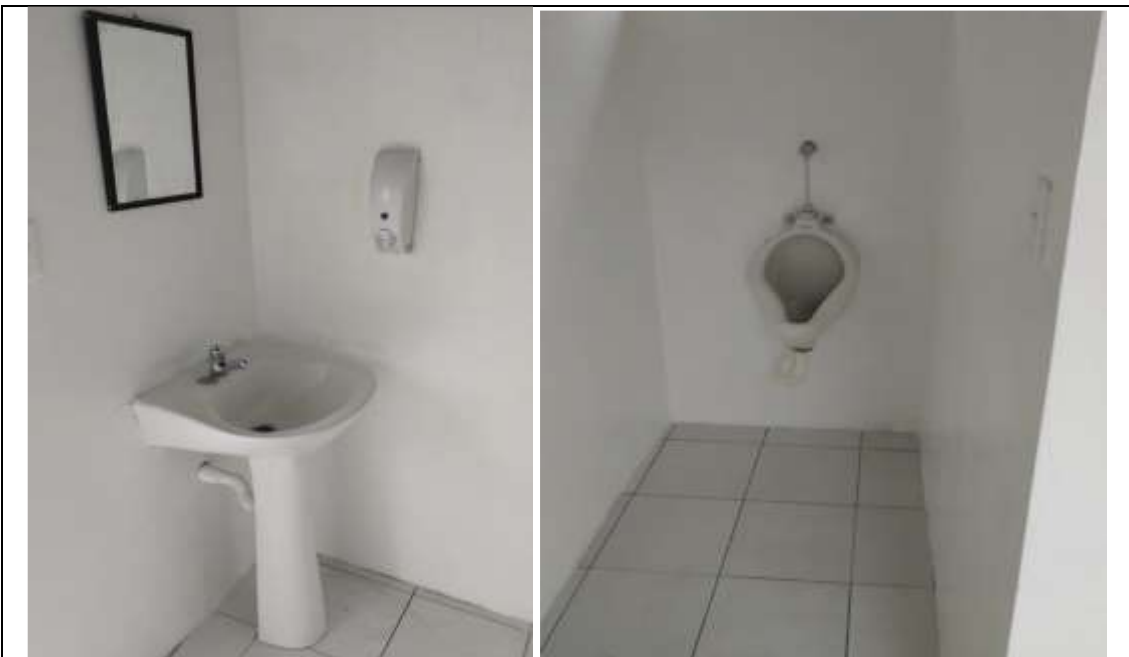
Parte interna de las baterías sanitarias
