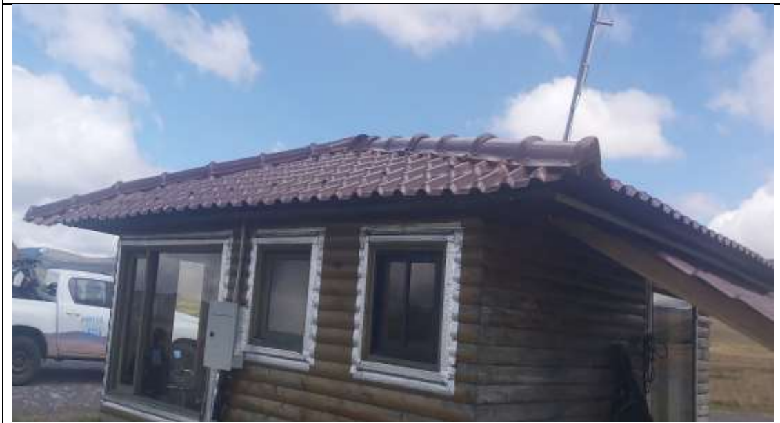
Cambio de cubierta de la guardianía de la ovejería de Antisana
