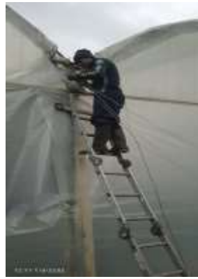
Rehabilitación de invernaderos, apertura de ventanas y cambio de cables que sostienen la estructura, Oyacachi.
