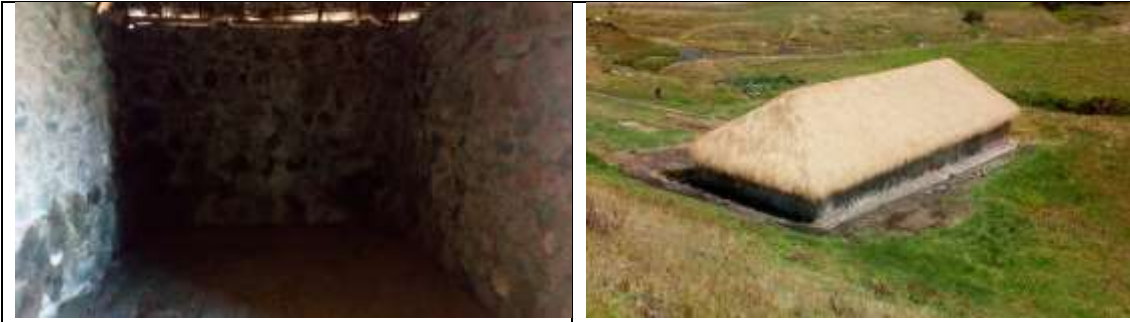
Fase final de rehabilitación de la Casa Patrimonial Humboldt
