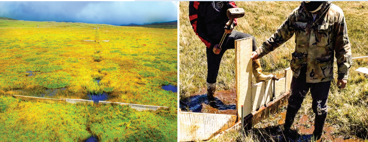
Figura 8. Bloqueo de drenajes mediante diques de madera
