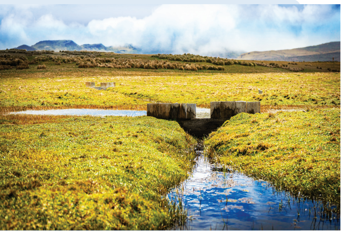
Figura 21. Bloqueo de drenaje
