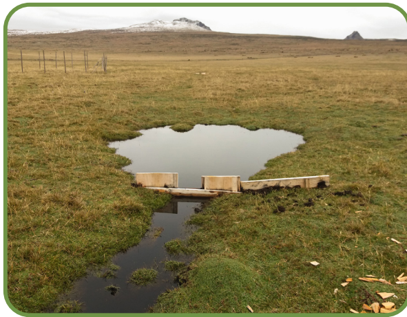
Fotografías: (a) Bloqueo a la salida de una poza y (b) Bloqueo en un drenaje
