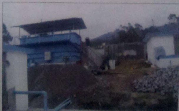
Avanzan las obras de captación del agua del Proyecto Pesillo-Imbabura que abastecerá a cerca de 20 000 personas
