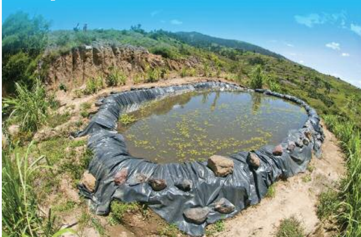
Piscina recolectora de agua lluvia
